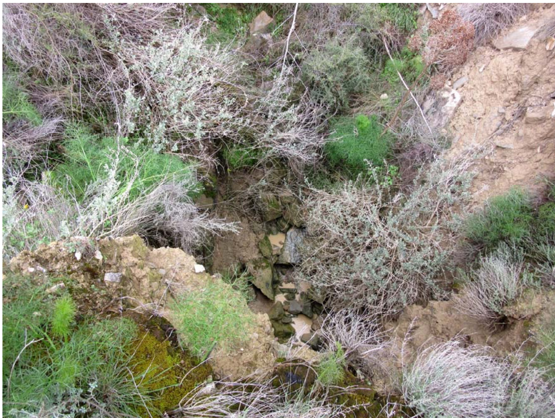
Figura 36. Claraboyas en la zona del puente de la cota +17 m y continuación superior del barranco, con un pequeño cauce temporal profundamente entallado entre las laderas del Barranco del Gato.
